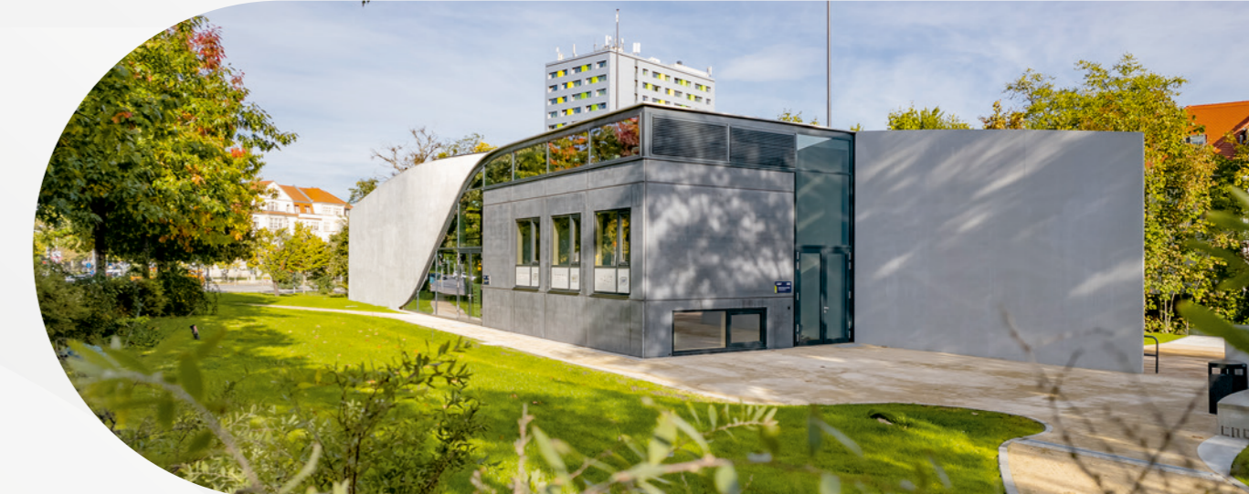
Die Menge des weltweit am zweithäufigsten verwendeten Materials, Beton, kann durch den Einsatz von Carbonbetonstrukturen um bis zu 80 % reduziert werden.
